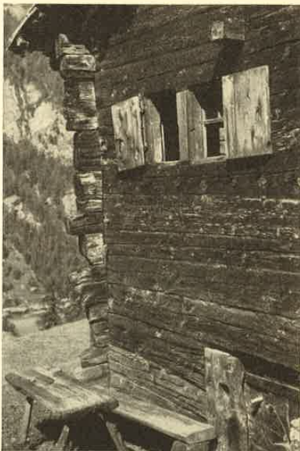
Fig. 3. Paroi extérieure, côté sud.
